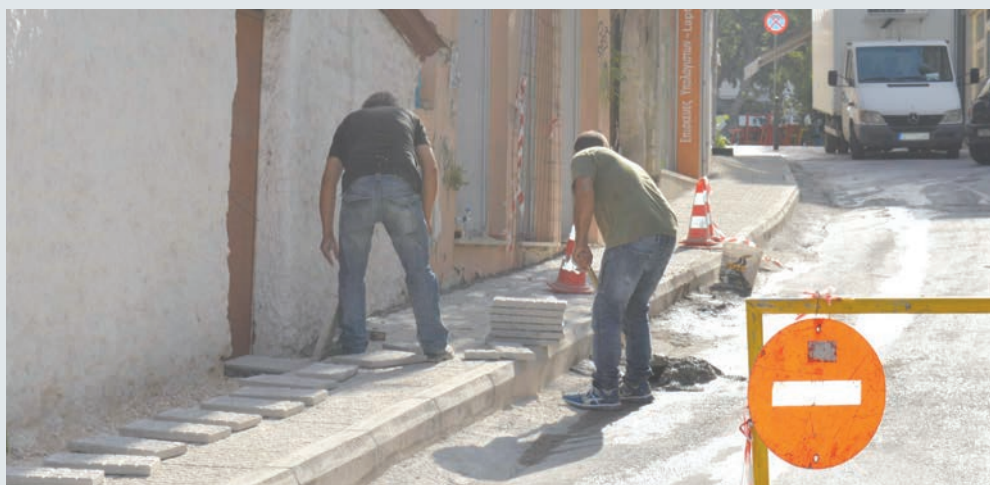
Λεωφόρος Αθηνών: Κατασκευή Πεζοδρομίων
